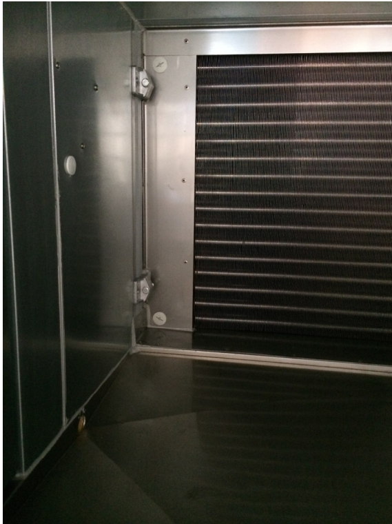
Bild 2: Ausführung der Wasserwannen
