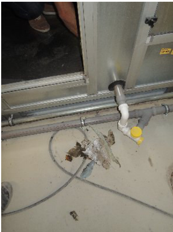
Bild 5: Ablauf außen mit Siphon
